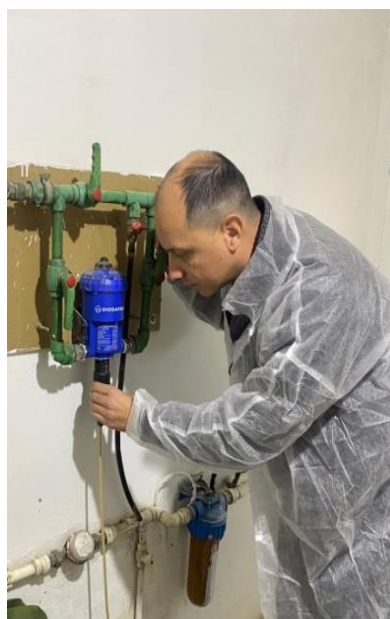
Рисунок 6 – Дозирующий медикатор (Dosatron D25) в системе водопоения бройлеров кросса «COBB 500 FF»
