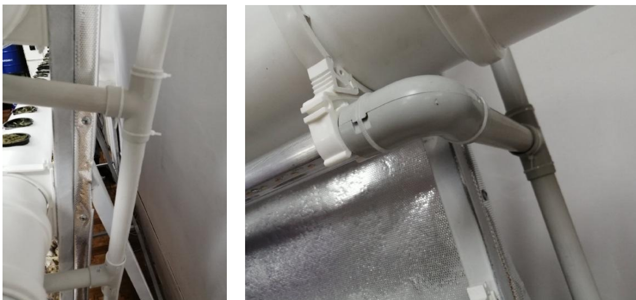
Рисунок 8 - Установка токоведущих частей светильников в кабель-канал
